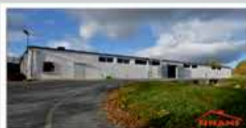
HALA PRZEMYSŁOWA BURGRABICE 61ar, 868m2, budynek ocieplony
